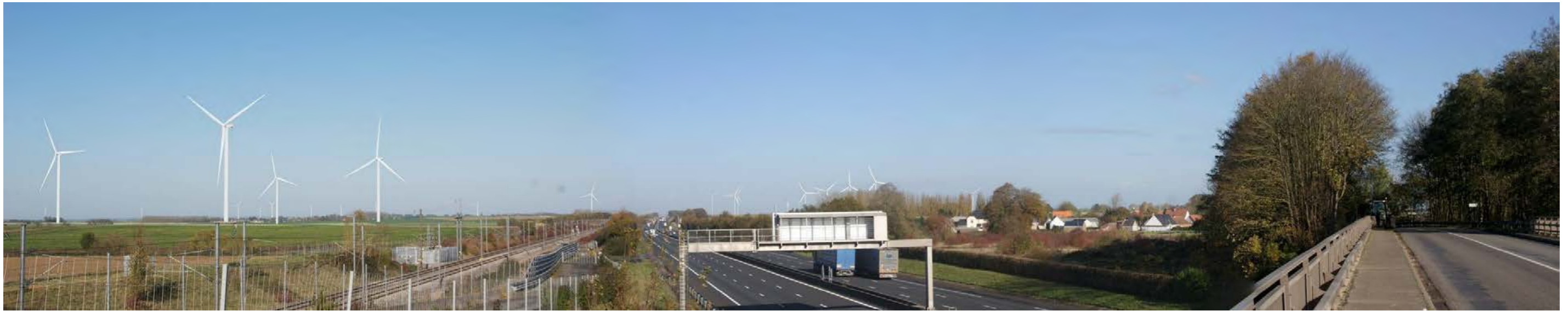
Vue panoramique - Etat initial
