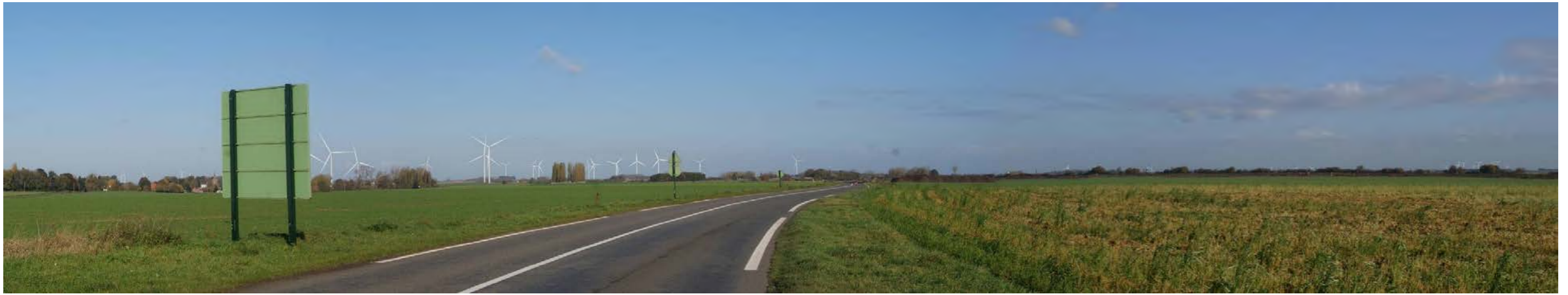
Vue panoramique - Etat initial
