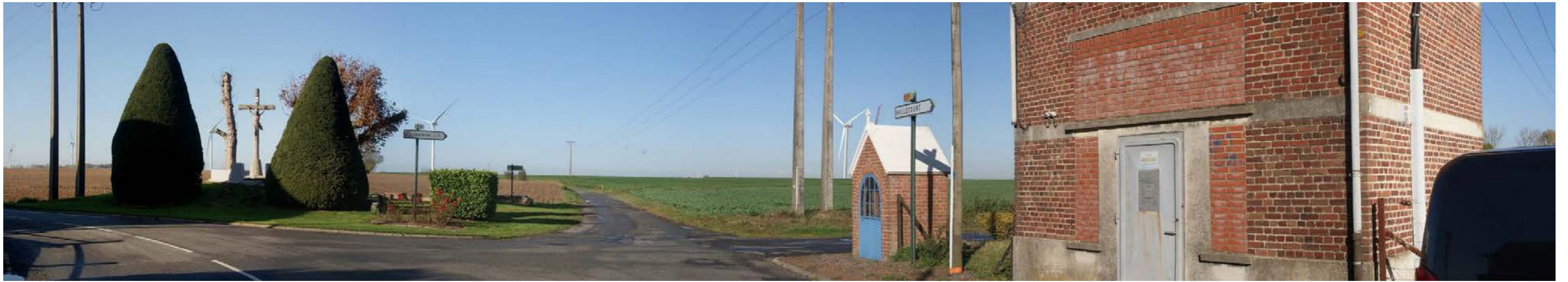
Vue panoramique - Etat initial
